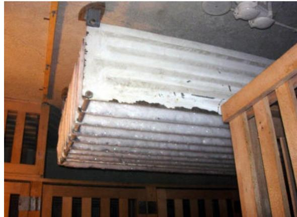
Abb. 4: Die Kühlrippen im Gefrierraum des Kalthauses Hallstedt. Foto: 2007.
